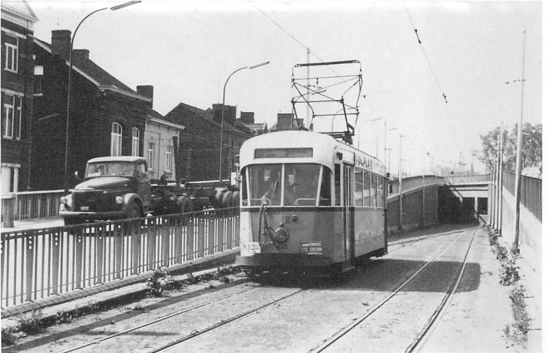
Un service "Gare du Nord - Loverval", service partiel de la ligne 9, montant la trémie spécialement aménagée route de Philippeville et permettant aux tramways de se placer dans l'axe de la chaussée. (Photo J.-M. Pholien)
